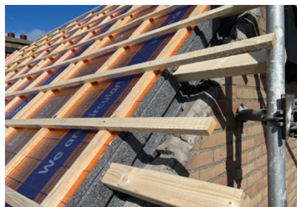
Praktijkvoorbeeld kopgeveloverstekvoorziening
