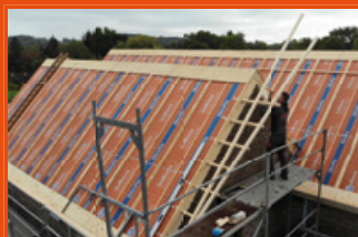
SlimFix Flex maatwerkoplossingen (renovatie)
