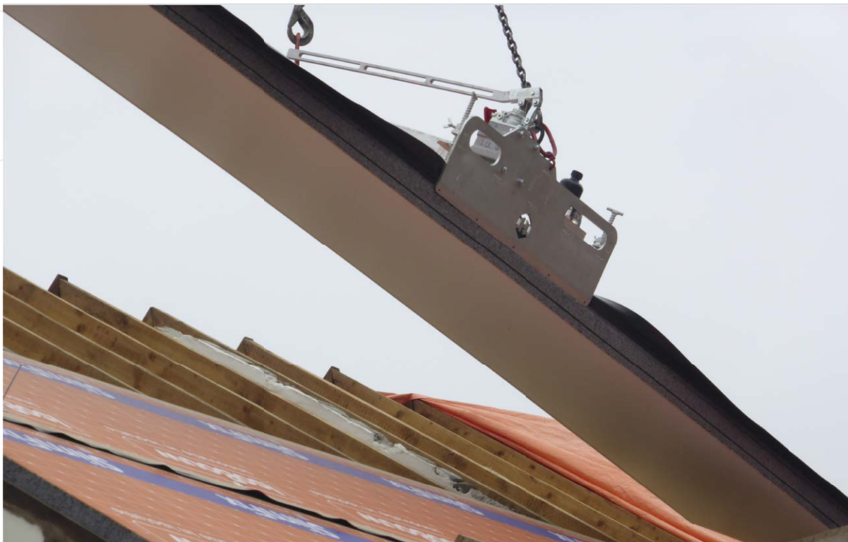
Te monteren met een HTZ dakplatenklem
