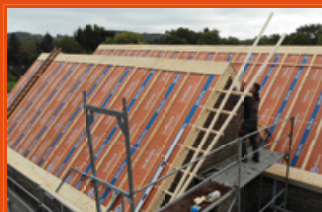
SlimFix Flex maatwerkoplossingen (renovatie)
