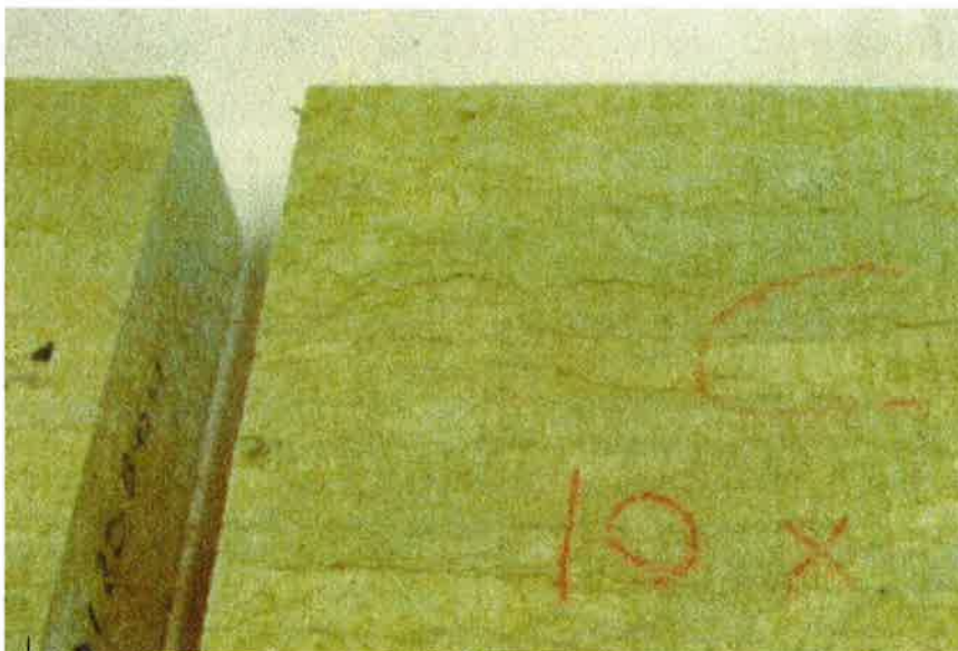
Figuur 5. Proefstuk van steenwol in 2 dichtheden, na 10 belastingscycli: weinig uiterlijke beschadiging, maar de druksterkte is met ruim 80% teruggelopen. Dit soort resultaten wordt ook in de praktijk (bij schadegevallen) vastgesteld.
