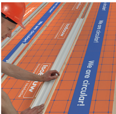
Uniek naadprofiel voor een snelle waterdichte aansluiting
