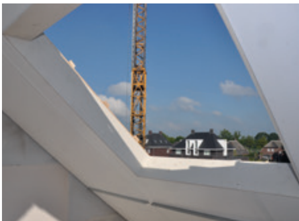
Fabrieksmatig aangebracht dakvenster met aftimmering
