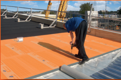
plat dak isolatie
