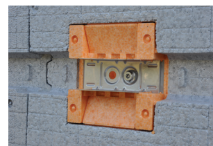
Controle: als de plug+schroef na licht aandraaien niet meedraait is de plug correct gemonteerd. Eventueel voorzien van spray.
