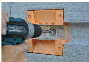
Aandraaien van schroef totdat schroef tegen nylon plug aan ligt.
