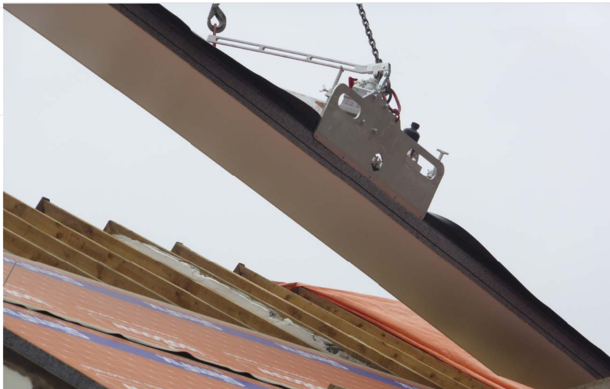
Te monteren met een HTZ dakplatenklem
