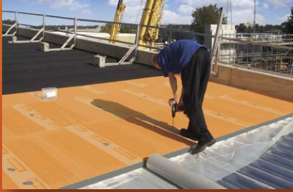
plat dak isolatie
