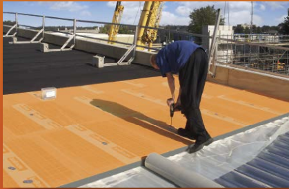
plat dak isolatie
