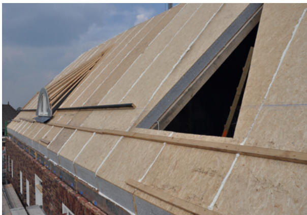
Met SlimFix XT ® Riet een langere levensduur van het rieten dak
