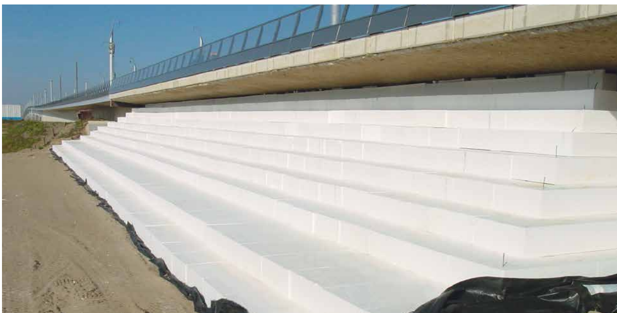
Airpop® als zettingsvrij materiaal bij HSL-brug Moerdijk
