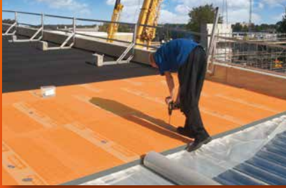
plat dak isolatie
