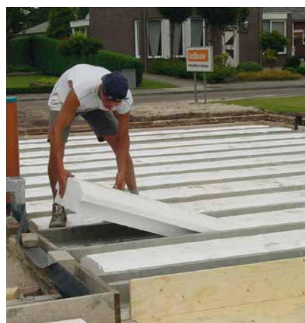
Toepassing vloerisolatie door middel van vormdelen
